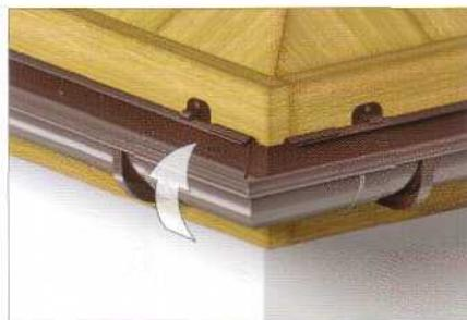
**9** Установить угольники на желобе. Вложить задний фланец желоба в задний фланец угольника и защелкнуть передний фланец желоба в торцевом фланце угольника.
