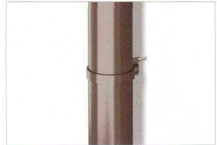
**13** Если необходимо установить хомут непосредственно на водосточной трубе, следует предусмотреть возможность перемещения водосточной трубы в хомуте.
