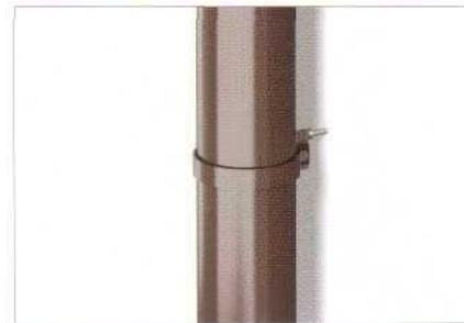
**13** Если необходимо установить хомут непосредственно на водосточной трубе, следует предусмотреть возможность перемещения водосточной трубы в хомуте.
